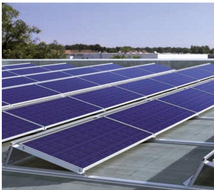
I moduli fotovoltaici della serie Vitovolt 300, prodotti in EU, vengono fabbricati secondo i più elevati standard qualitativi. Grazie ad un grado di efficienza del modulo che può raggiungere il 15,67%, è possibile raggiungere rendimenti solari particolarmente elevati.
